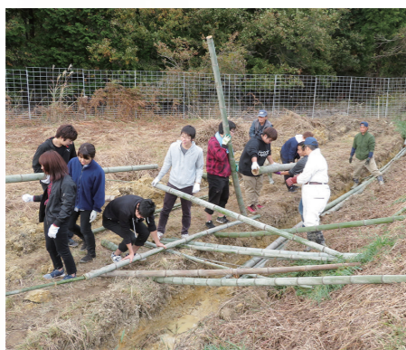
暗きょ敷設作業を手伝う様子
