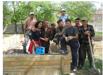
キルギスの建築現場
