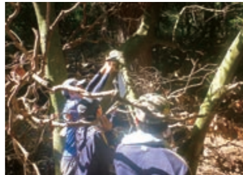
遠隔受信装置（ハブ）の設置作業
