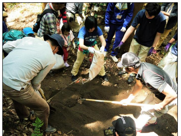
図7 道普請に関するワークショップ 新型土のうによる林道整備も実施した
