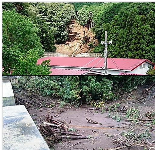
図1 校内でも発生した土砂災害(H27.9)。砂防ダムを越え、校舎(赤い屋根)脇まで土砂が堆積
